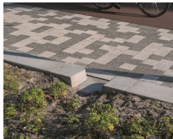
Wadigootband bij het Jan van der Heijdenplein. Zo kan regenwater de groenvakken instromen en zijn de groenvakken beschermd tegen het inrijden van auto's
