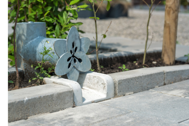
Bovengrondse uitstroomvoorziening langs de regentuinen Leverancier: Rainworks -BU-HWA bloem + vlinder
