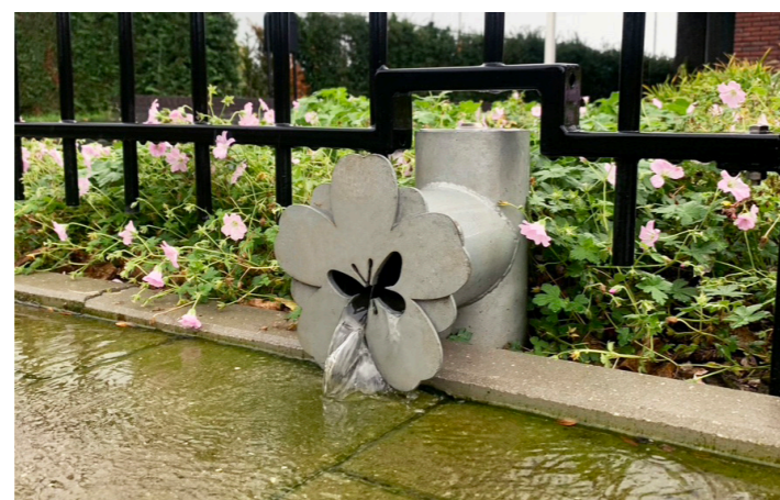
Bovengrondse Uitstroomvoorziening Hemelwater Afvoer (BU-HWA) Leverancier: Rainworks
