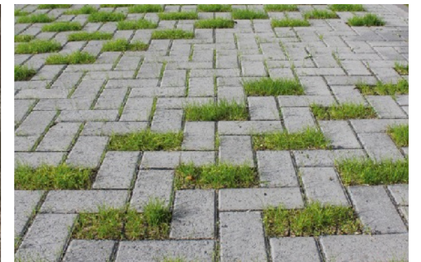
Grasklinkers in parkeervakken met Greenbricks zorgen voor infiltratie van regenwater. Door de begroeiing met gras wordt de doorlatendheid van de bodem bewaakt.
