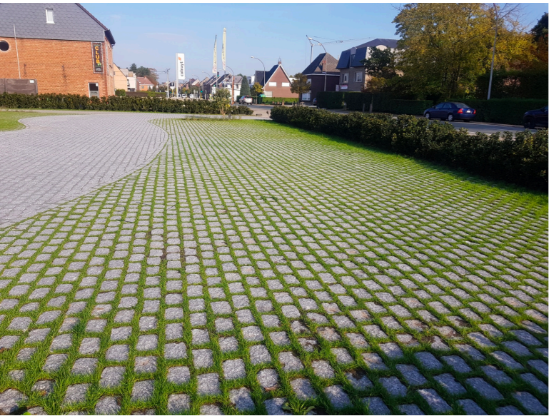
Parkeervakken van kasseien met open voeg, voor groene uitstraling en infiltreren van regenwater
