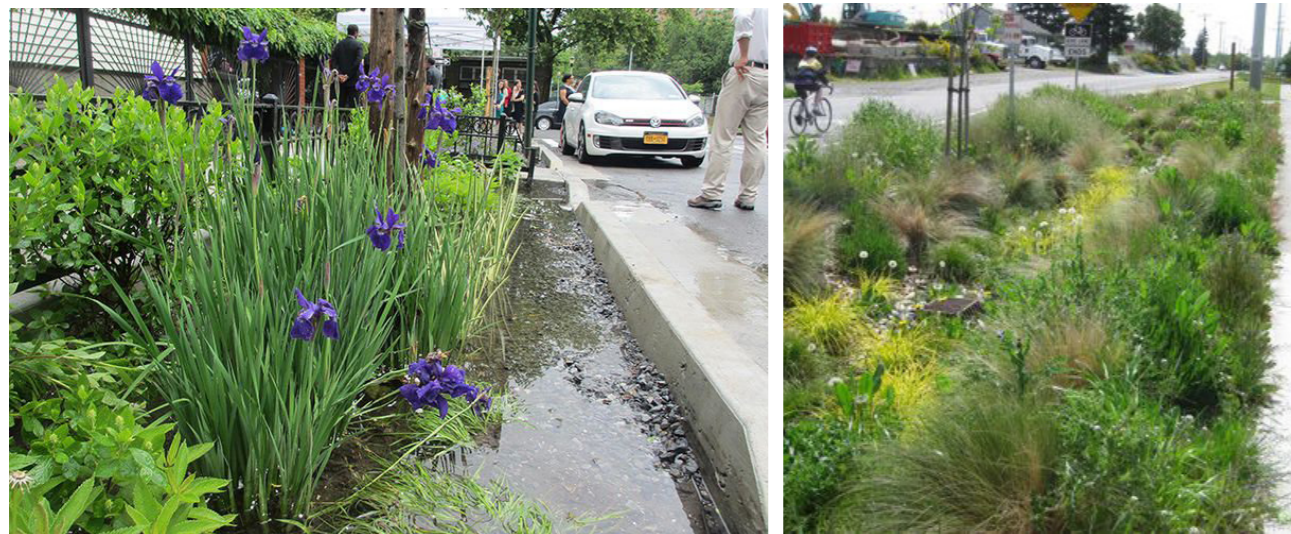
Groenstroken voor de opvang van regenwater in straten en het Jan van der Heijdenplein. In de plantvakken kan regenwater worden opgevangen en geïnfiltreerd
